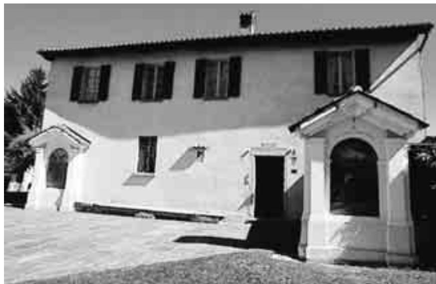
Gli approfonditi lavori di ristrutturazione prenderanno avvio a settembre.
